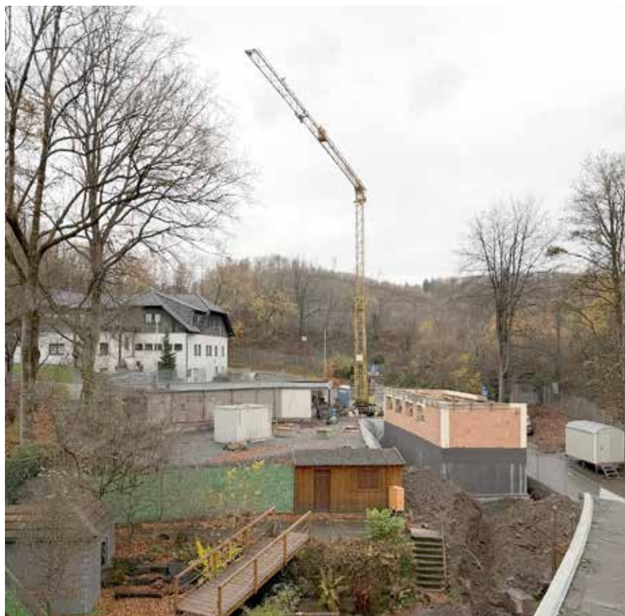
Bauphase des neuen Kiosks Foto © Moritz Voßbeck
