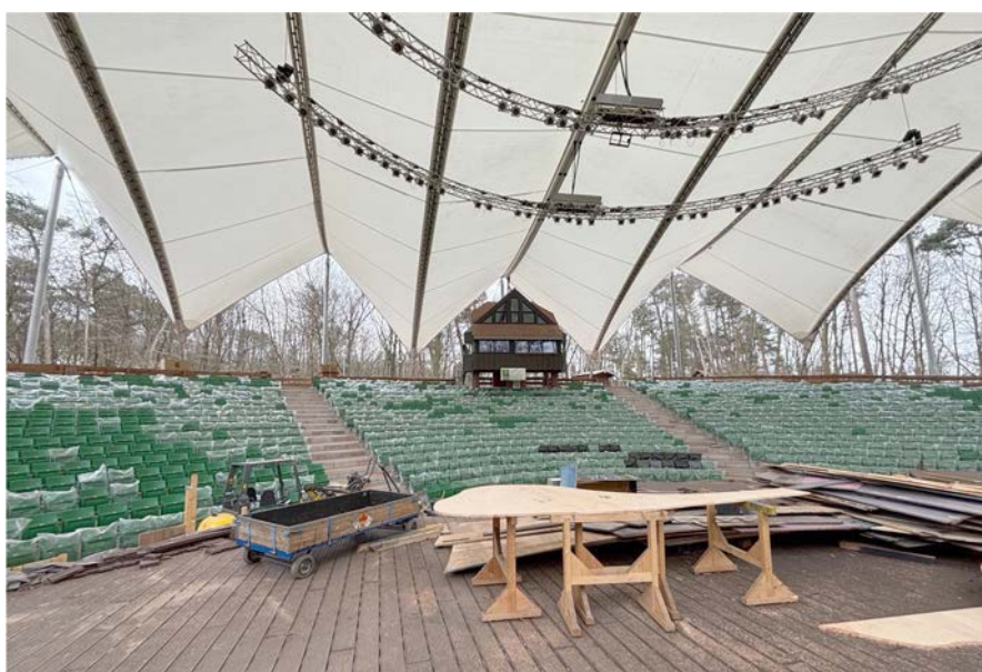
Die Tribüne im Umbau
