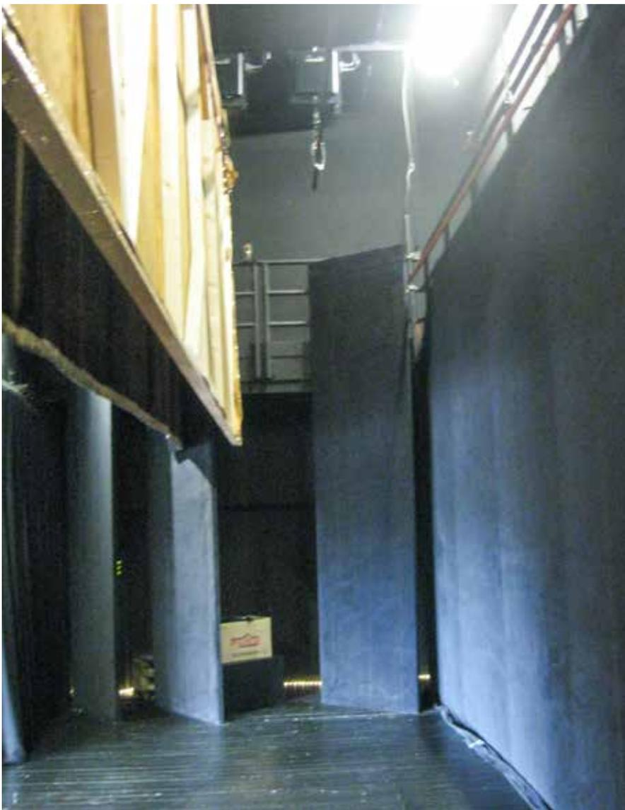
Ein Blick auf den Schürboden, der mit Bandzügen und Laststangen so ausgestattet ist, dass drei verschiedene Kulissen zum Einsatz kommen können
