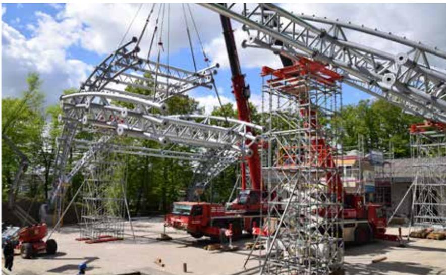
Ein gewaltiger Autokran hievte die Teile der Stahlkonstruktion für das neue Zuschauerdach am Passionsspielgelände Sömmersdorf in die Höhe
