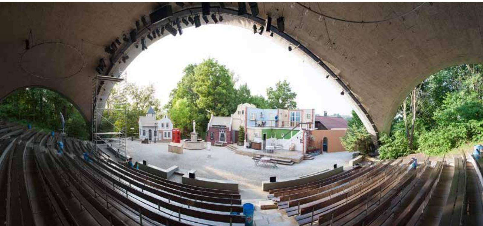
1978 entstand die Überdachung des 850 Sitzplätze umfassenden Zuschauerraumes als frei geformte Stahlbetonmassivschale ohne sichtbehindernde Stützen, ein architektonisches Meisterwerk
